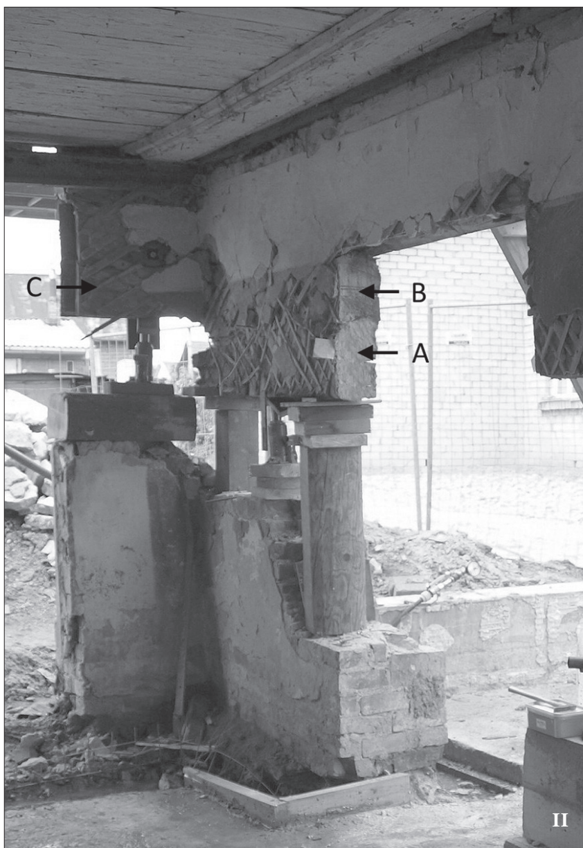
A – mūrlata virs, domājams, 20. gs. pirmajā pusē uzmūrētā sienas apakšējās daļas mūra; B un C – dendrohronoloģiski datētie sienas pildījuma oriģinālie baļķi
