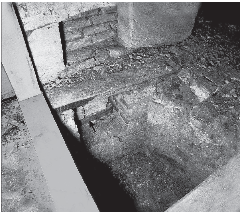
1. att. Rīgas pils Svina torņa bēniņu stāvs. No ārpuses aizmūrētā šaujamlūka ar tās apakšdaļā daļēji redzamo vaļņu bises balsta ozolkoka pamatni (norādīta ar bultiņu)
